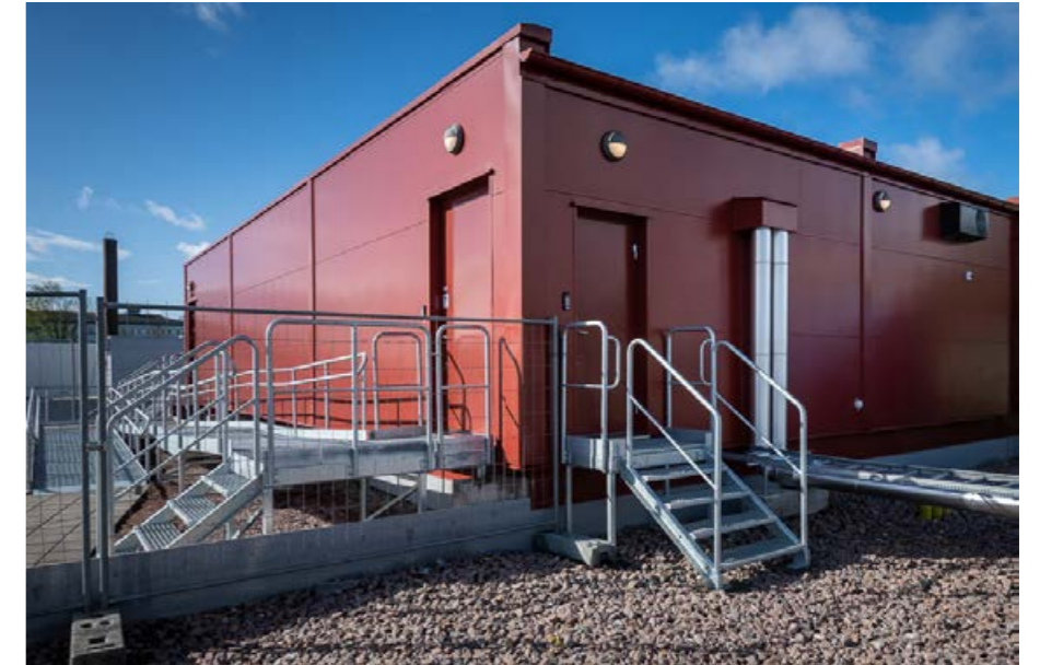
Edge datacentermodul Foto; Swedish Modules
